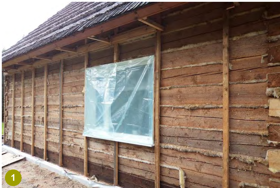
Foto 1 - Märgpaigalduseks ette valmistatud vana palksein.
